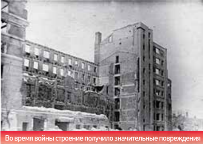
Во время войны строение получило значительные повреждения
